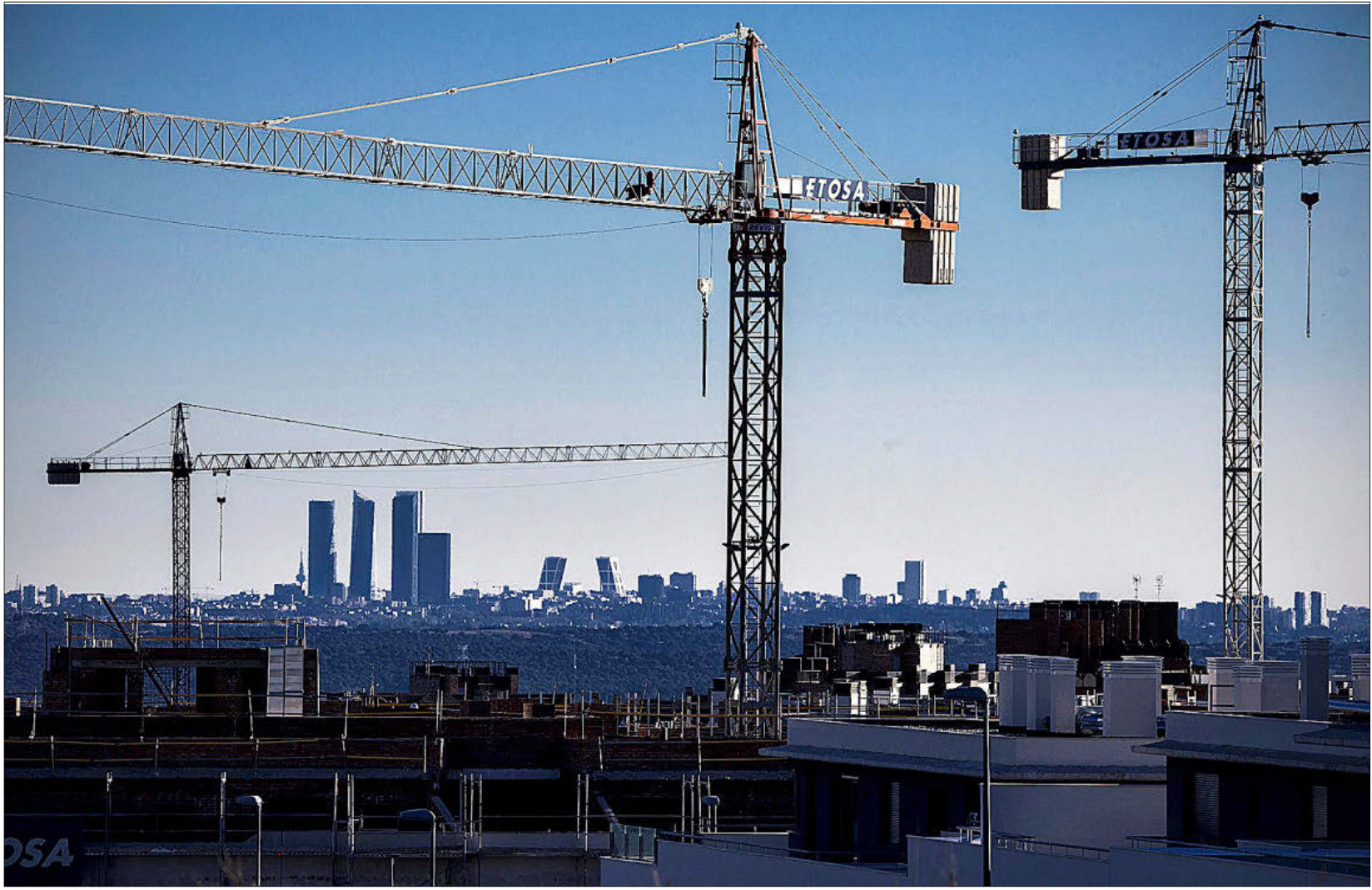
Edificios en construcción en Colmenar Viejo, al norte de Madrid, con la capital al fondo. ALBERTO DI LOLLI
